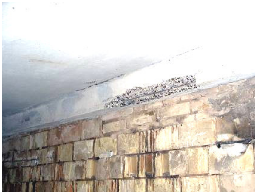
Рисунок 3 – Стан зовнішніх шарів кладки поперечної стіни і поздовжнього ребра шатрової плити перекриття
