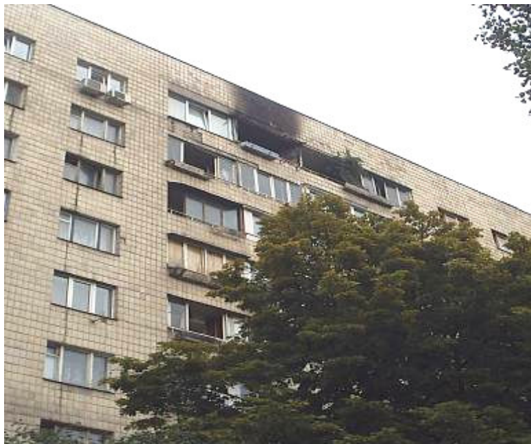
Рисунок 1 – Фрагмент фасаду будинку з наслідками пожежі
