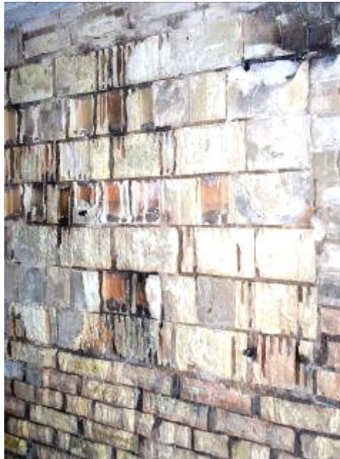
Рисунок 2 – Стан зовнішніх шарів кладки поперечної стіни
