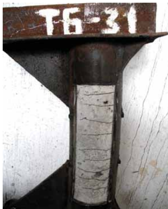
Рис 3 – Вигляд бетонного ядра у зразку серії ТБ-31 після випробування 1. Коефіцієнт ефективності роботи бетонного ядра в трубі
