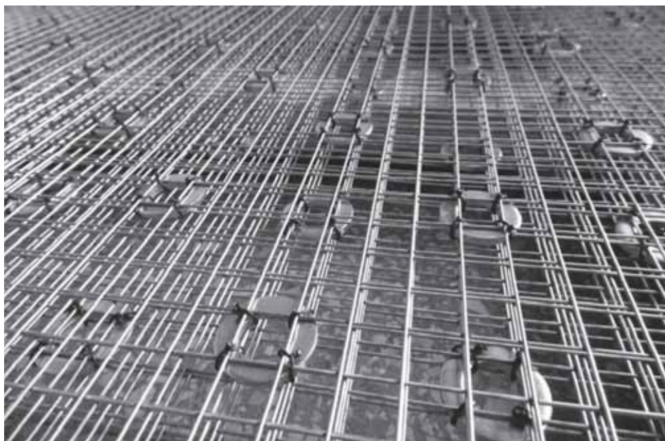
Рис. 1 – Арматурні сітки плити
