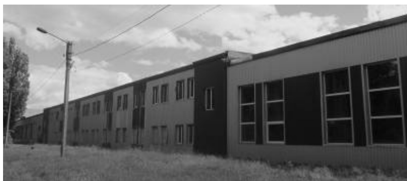
Рисунок 2 – Загальний вигляд нефункціонуючої будівлі заводу «Полтавафарфор» по вулиці Маршала Бірюзова, 37
