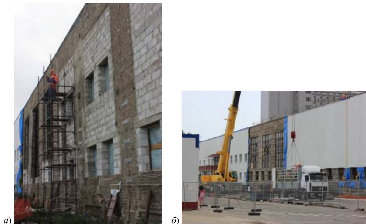
Рис. 2. Закладання частини віконних прорізів (а) та влаштування теплоізоляції зовнішніх стін (б)
