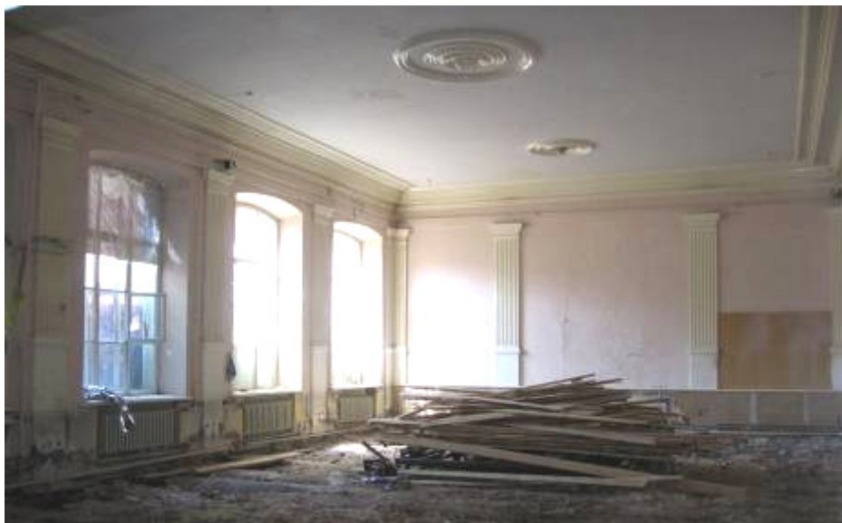
Рис. 2. Общий вид рекреационного зала, вид торцевой стены (ось «Е») и частично стены по оси «8/1»
