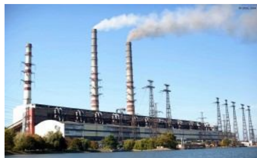
Рис. 1. Викид в атмосферу шкідливих речовин з двох 250-метрових й однієї 180-метрової труби Бурштинської ТЕС в східному напрямку
