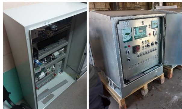
Рис. 5. Телекомунікаційна шафа дистанційного керування роботою підстанцій
