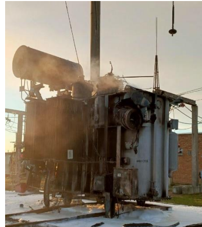
Рис. 2. Пошкоджений трансформатор та відкритий розподільчий пристрій підстанції 150/35/10 кВ
