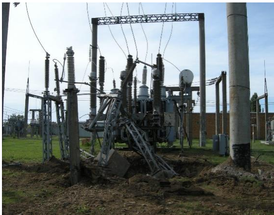
Рис. 2. Пошкоджений трансформатор та відкритий розподільчий пристрій підстанції 150/35/10 кВ
