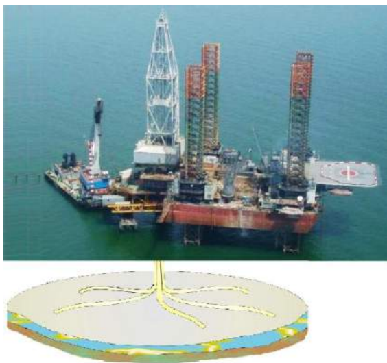
Рис. 1. Куст пяти скважин с горизонтальными стволами на Восточно-Казантипском месторождении (Смещение до 750 м).
