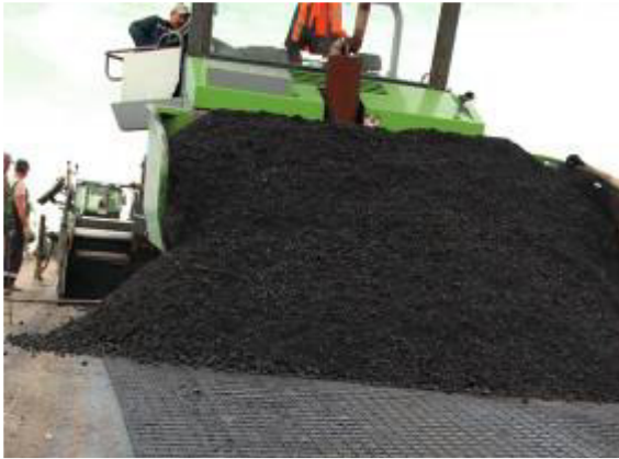
Рисунок 5 – Застосування дорожньої сітки ПСБ-Д при будівництві доріг
